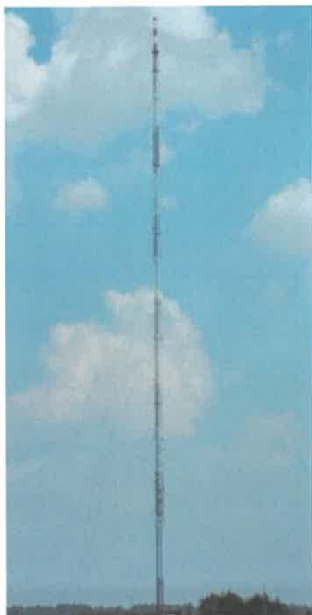
Fot. 1. RTCN Częstochowa / Wręczyca Wielka – widok obiektu
