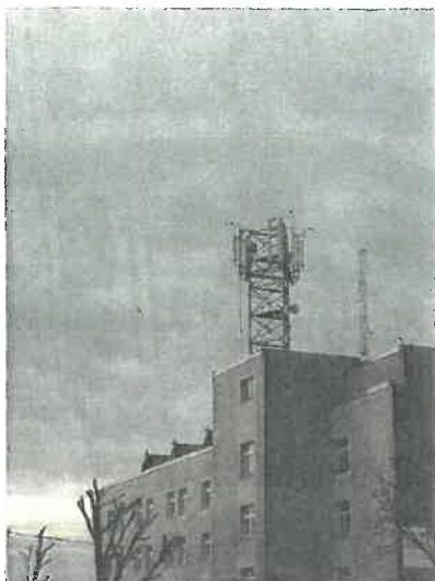
Widok obiektu wraz z zainstalowanym zespołem antenowym
